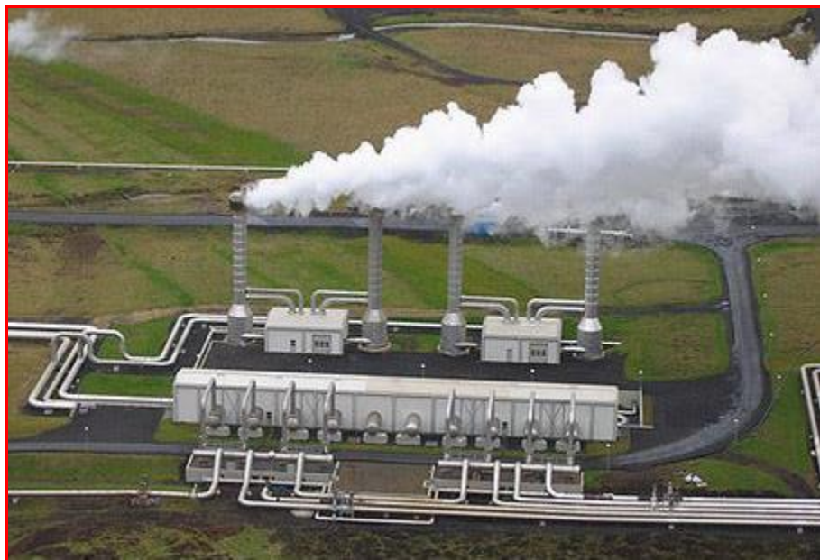
Şekil 3.2 Jeotermal Elektrik Enerjisi Santraline ait görünüm.
